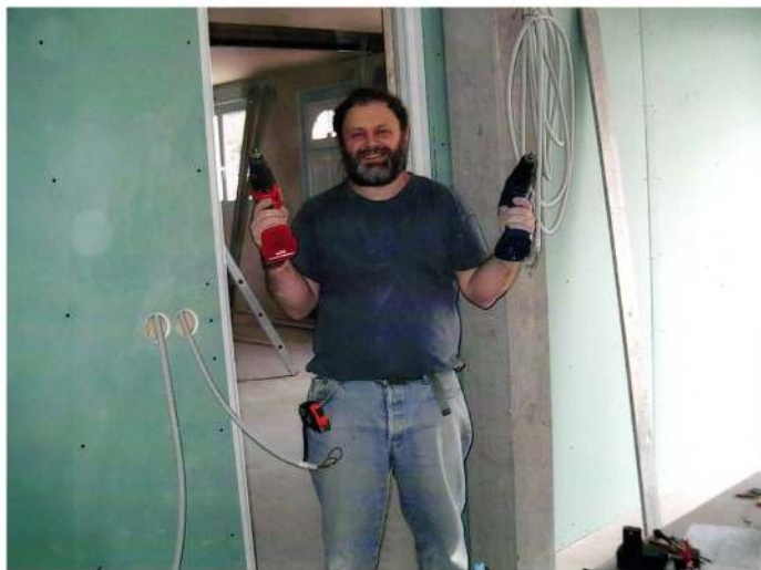
Figure 15. En 2008, Thierry Frétey, armé de deux visseuses, poursuit l'aménagement intérieur de sa maison de Saint-Maugan (Ille-et-Vilaine). Photo Mathilde Frétey.
